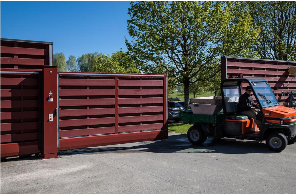
Geöffnet mittels Induktionsschleife im Boden eingelassen (innen + aussen). Zusätzliche Funksteuerung.
